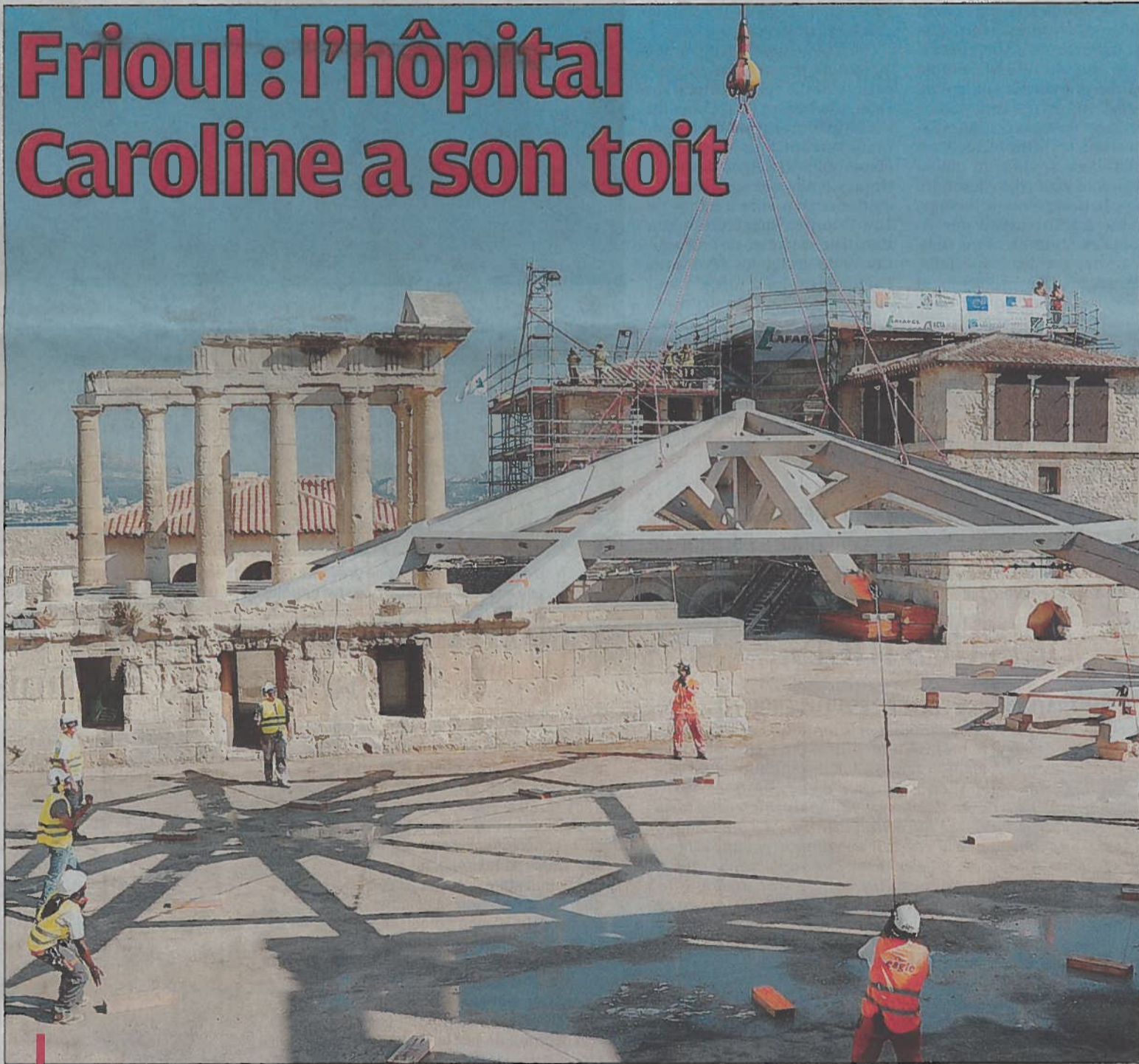
Dans le cadre de la restauration du monument historique, l'héliportage d'une imposante charpente a été réalisé avec succès, hier. / PHOTO P. SCHIPMAN p.7
